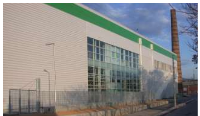
Ανατολική όψη του κτηρίου
