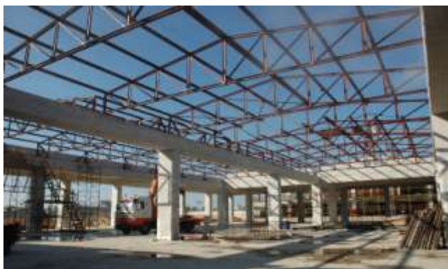
Μεταλλική Στέγη σε φάση κατασκευής
